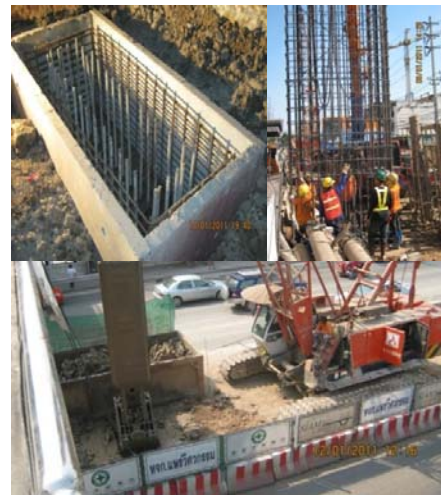
รูปที่ 4 การเจาะเสาเข็มเจาะชนิดทรงสี่เหลี่ยมและระบบไม้แบบสำเร็จรูปสำหรับงานฐานราก
