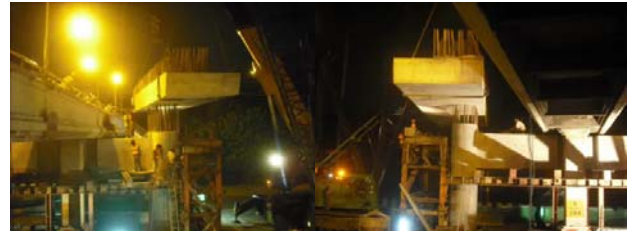
รูปที่ 6 งานประกอบติดตั้งชิ้นส่วนสำเร็จรูปที่หน้างาน
