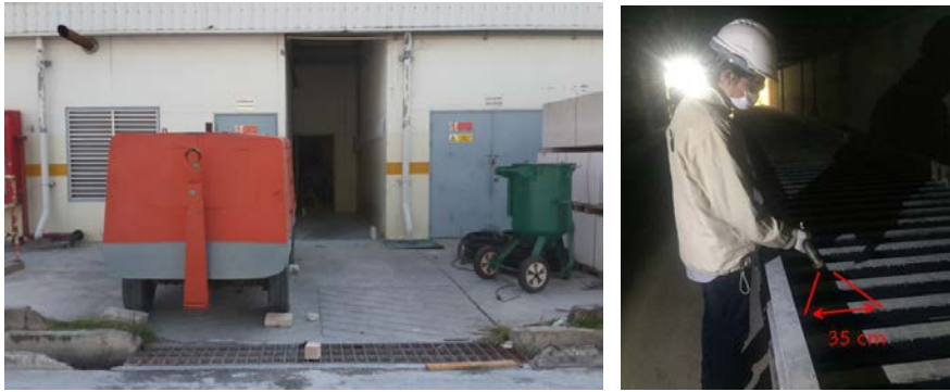
รูปที่ 6 เครื่องพ่นทรายแบบเคลื่อนที่และการทดสอบพ่นทรายทำความสะอาดแท่นรองรับคอนกรีตมวลเบา
