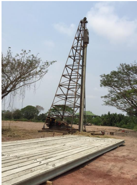
ภาพที่ 1 เสาค้ำตอกด้วยปั้นจั่นยกลูกตุ้มปล่อยให้ตกกระทบที่หัวเสาค้ำ (drop hammer)
